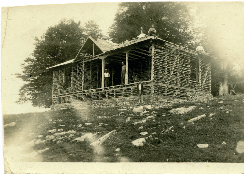
Строителство на хижа „Узана” в Стара планина, 1930 – 1931 г.
