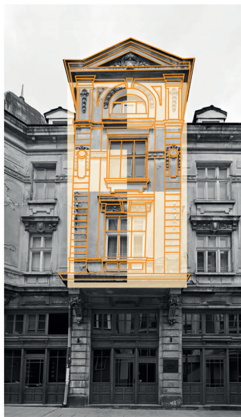
Източна фасада на сградата, 2024 г. Заснеч. Й. Николова
