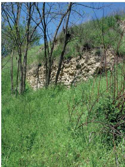
Обр. 11 Изглед на водопровода от запад в м. „Късовата воденица“
