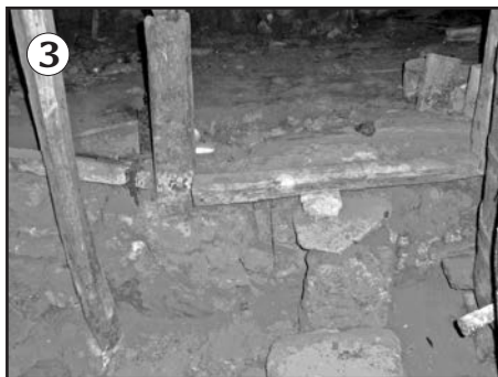
Землянката отвътре. Зидана е от каменни блокове, покрита с коноп (гръсте)
