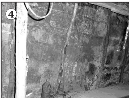
Землянката отвътре. Зидана е от каменни блокове, покрита с коноп (гръсте)
